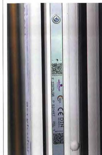
Das Selbstklebeetikett mit den zwei QR-Codes für die unterschiedlichen Zielgruppen wird unterhalb des Griffes auf die Beschlagstulp aufgebracht.
